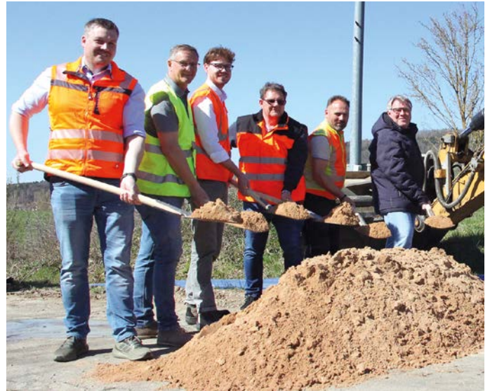
Projektleiter Stefan Popp, Eduard Hermann, Fa. Hermann Rohrbau, Johannes Gold und Max Brust, Planungsbüro Weyrauther, Bernhard Britting, Wassermeister Markt Igensdorf und 1. Bürgermeister Edmund Ulm (von links)
