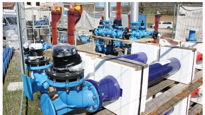
Die Oberflurhydranten warten an der Baustelle auf ihren Einbau.
