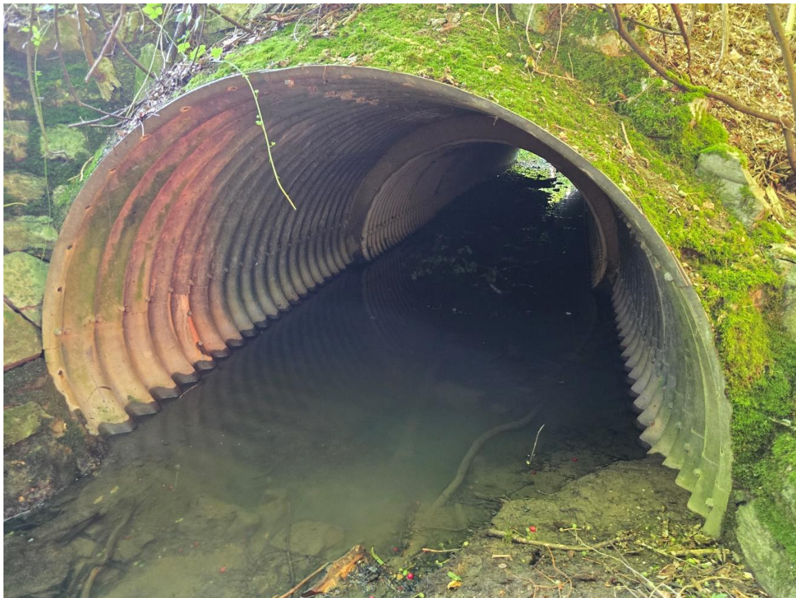
Bild 1: Blick von Oberstrom in das Bauwerk – Dimensionswechsel erkennbar
