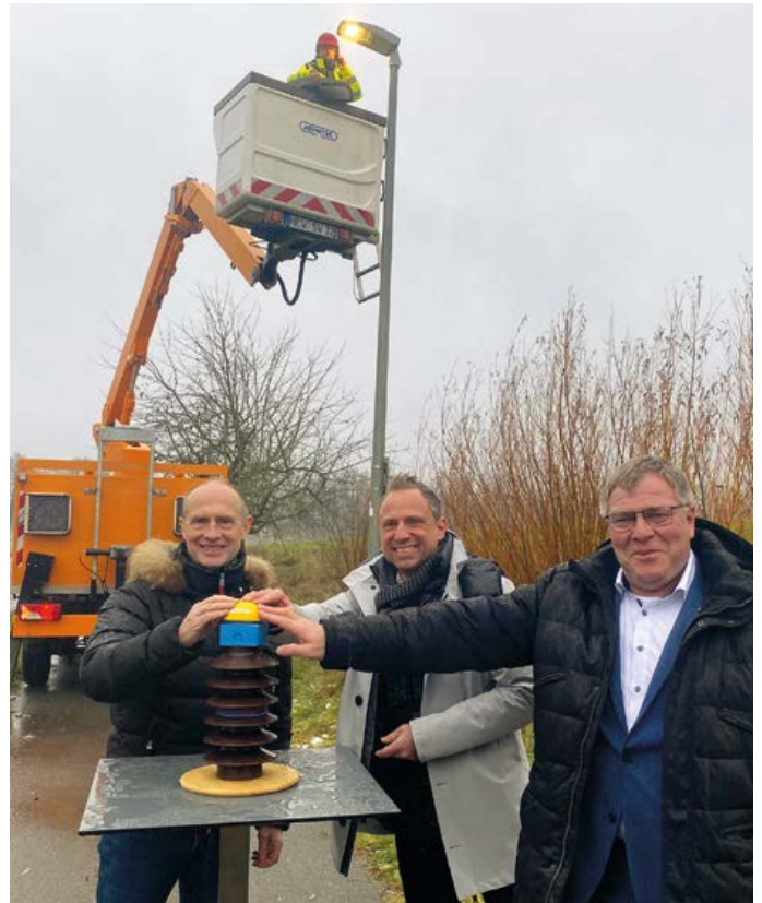
Drücken gemeinsam auf den gelben Knopf: Egon Leo Westphal, Thorsten Glauber und Edmund Ulm setzen die neue LED-Straßenleuchte in Betrieb.
